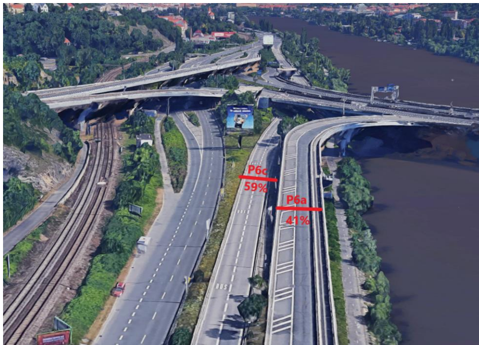
Obr. 22 Rozpad dopravy v prostoru P6 – příjezd z ulice Strakonická
